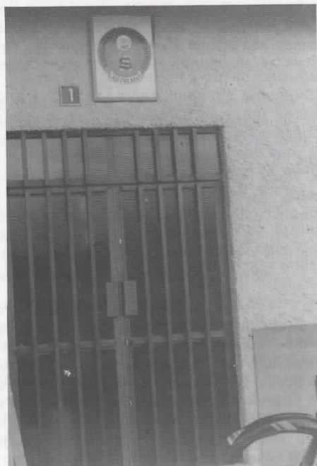
Fachada y puerta del nuevo local.
